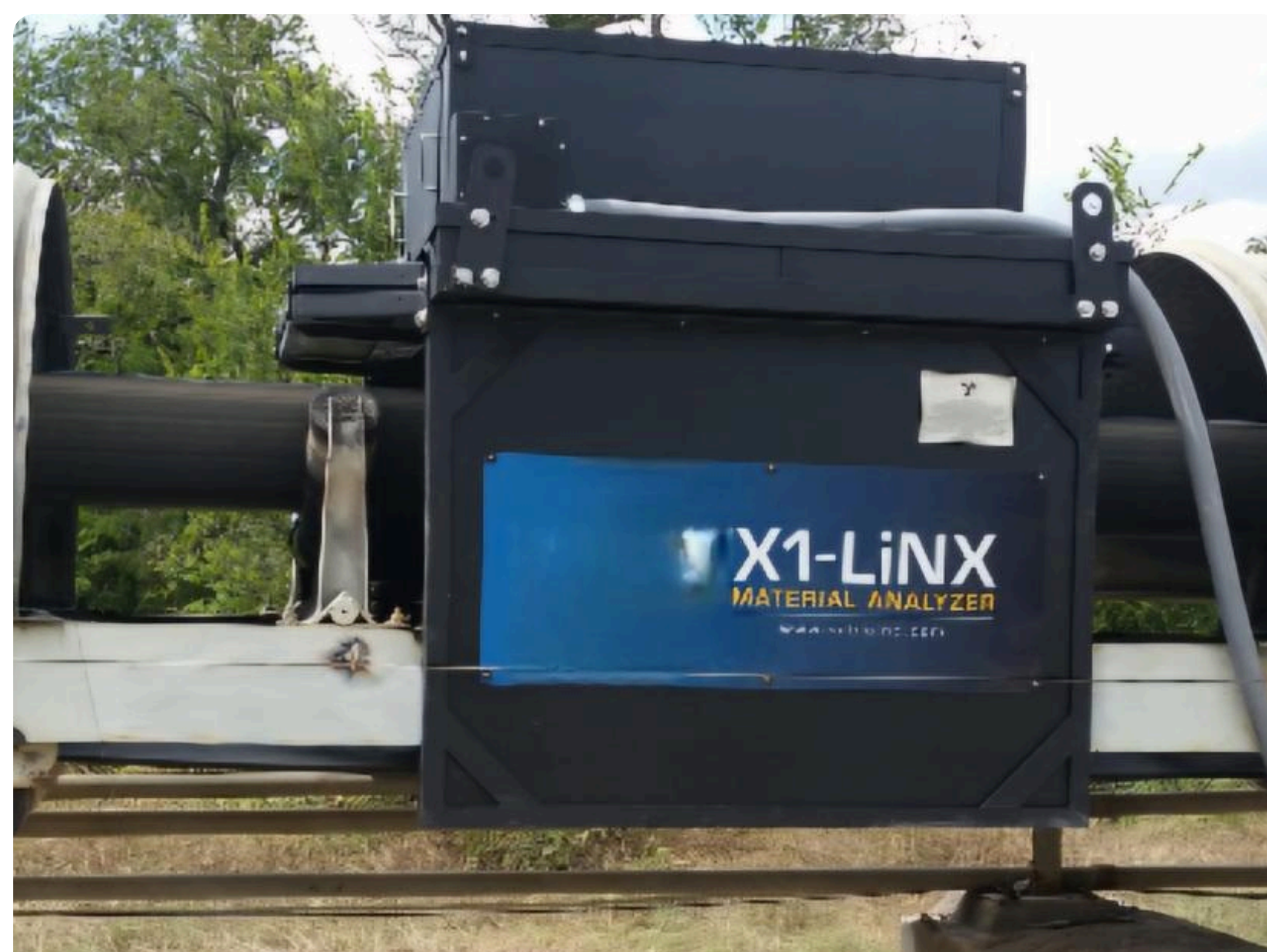
現場に設置された Cross-Belt Analyzer
